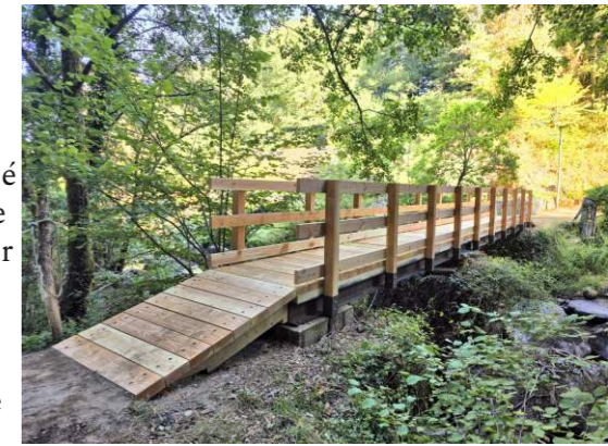
La passerelle terminée
